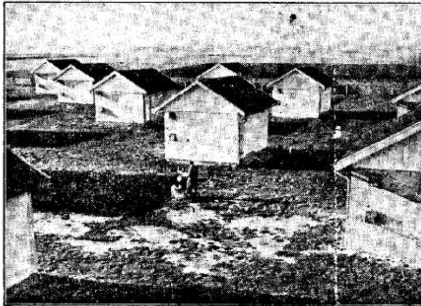
Von oben gesehen gleicht ein Haus dem anderen, aber Jedes ist aus anderem Wandmaterial gebaut worden. Die Häuser stehen mit den Giebelseiten genau in Ost-West-Richtung und haben einen so großen Abstand voneinander, daß sie sich nicht gegenseitig beschatten oder Wind und Regen abhalten. (Bild: dpa)
