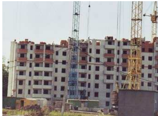
Bild 5: Hochhäuser in Ziegelbau, außen Kalksandstein, innen 3-Lochsteine in der Вул. Зодчих in Вінниця (Ukraine)
