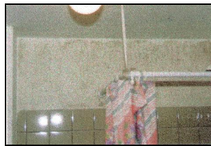
Bild 03: Badzelle mit Außenwand, vorher
